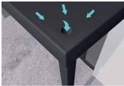
Izvedeni izljev i odvodna cijev u stupu
